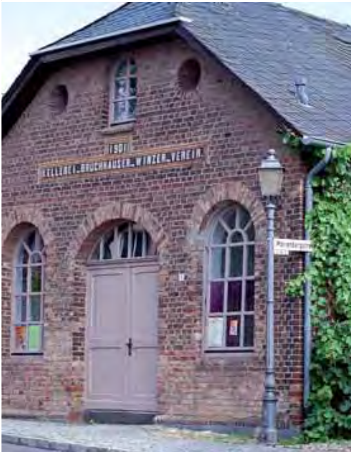
Kelterhaus, Pferdestall, Gemeindehaus: Das Winzergebäude von 1901
