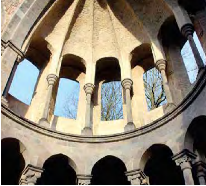
Heisterbacher Chorrueine, von Mönchen aus Stenzelberger Latit errichtet | Bilder: Martina Rohfleisch
