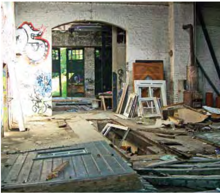
Verlassen, verwüstet und verwahrlost: Der alte Lokschuppen der Petersbergbahn | Bild: Archiv Dieter Mehlinski
