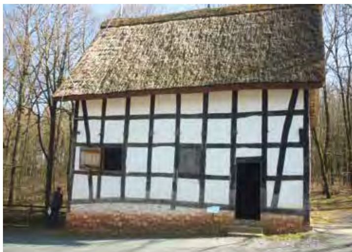
Kelterhaus aus Ockenfels bei Linz (abgebrochen 1975)
